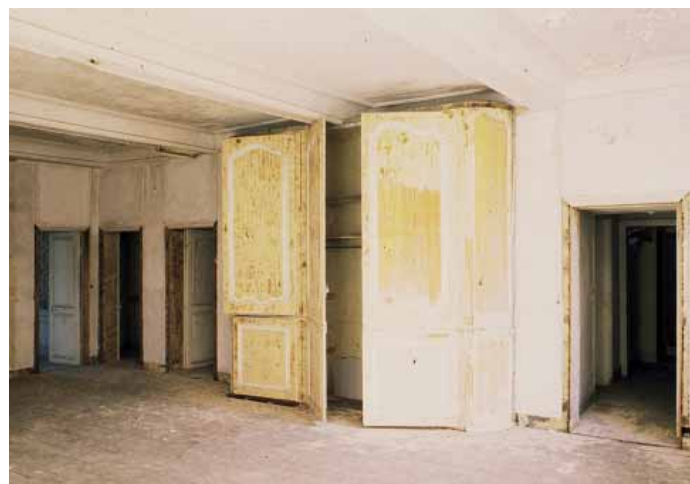
Het 'salon commun', voor en na restauratie.
